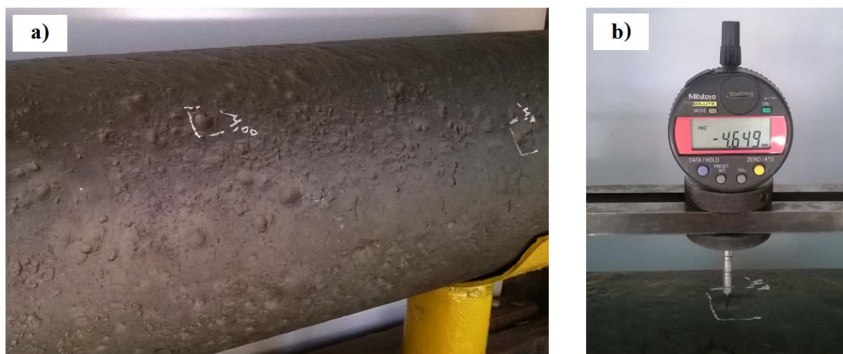
Fig. 7. Defecto volumétrico muy extendido de 1510 mm de longitud detectado en el Gasoducto Yofre (Defecto 1).
